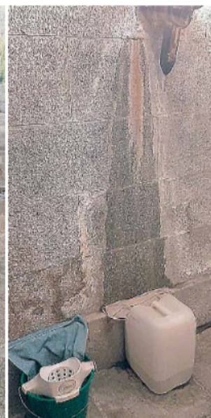
Trozos de esculturas de Juan de Ávalos en el suelo. Al lado, el rudimentario método empleado para recoger el agua de las humedades en la Basílica
